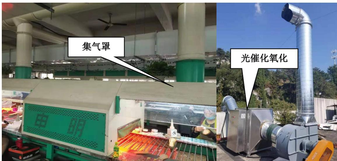
图 4-1 有机废气处理设施现场图
