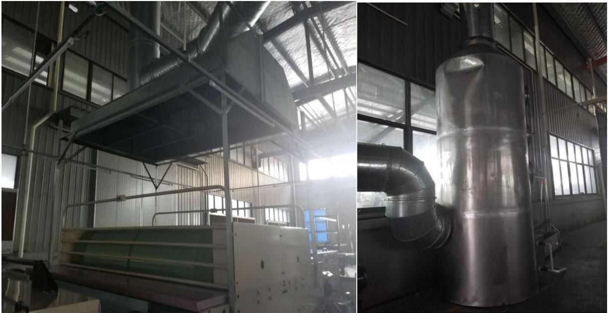
图 4-4 干燥废气处理设施现场图
